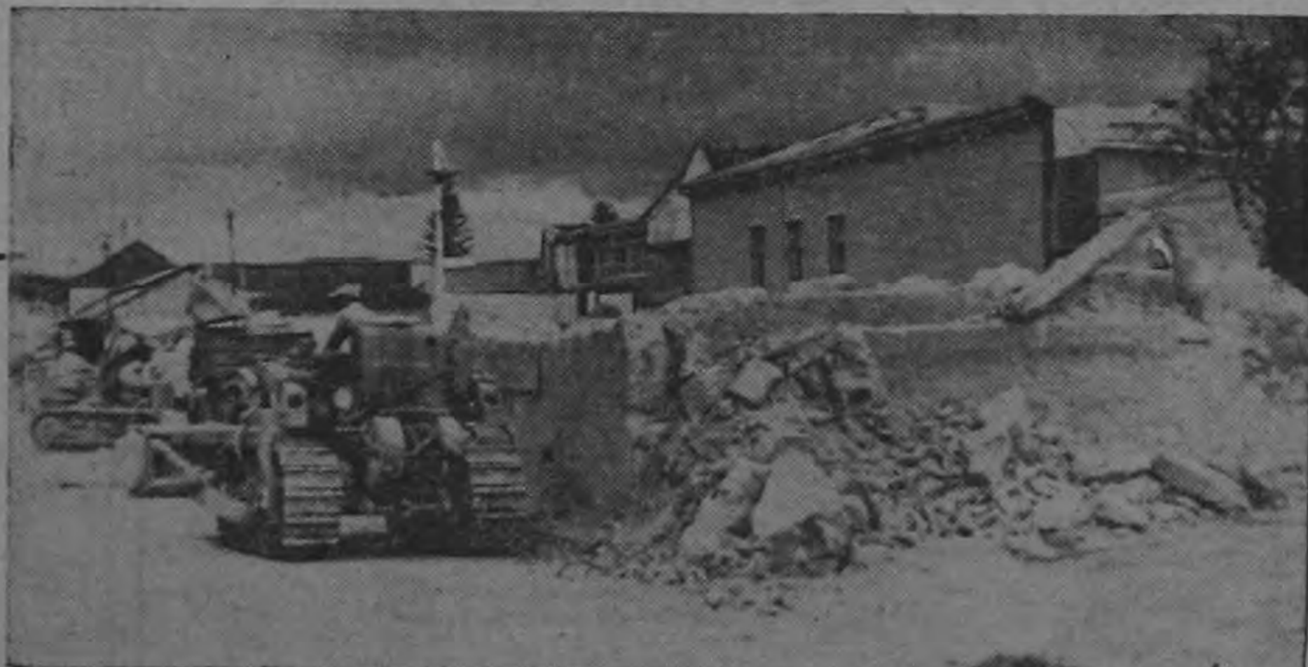
La Municipalidad de San José, aprovechando el comienzo de la estación seca ha reiniciado la demolición de los edificios públicos al lado sur de la Avenida Segunda. Los tractores comunales demolicieron ayer el antiguo edificio de la Universidad de Santo Tomás. Pronto San José tendrá su primera gran arteria para descongestionar las agobiadas calles capitalinas. (Foto Solano).
